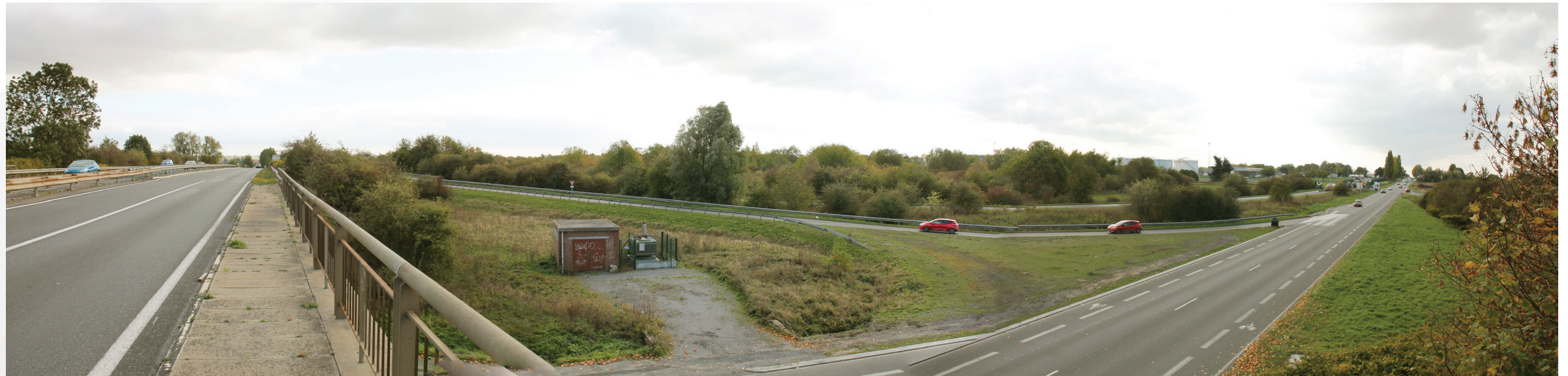
Site Total perçu à partir du pont de la départementale 40 au dessus de la Rd 630 à Haulchin.
