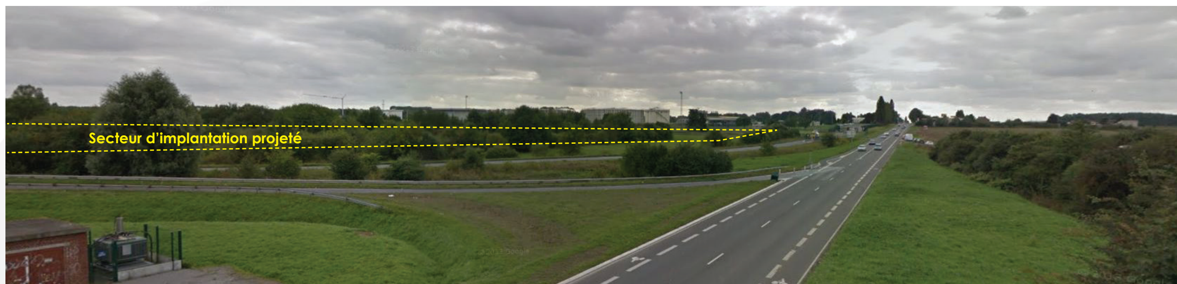
Site Total perçu à partir du pont de la départementale 40 au dessus de la Rd 630 à Haulchin.
