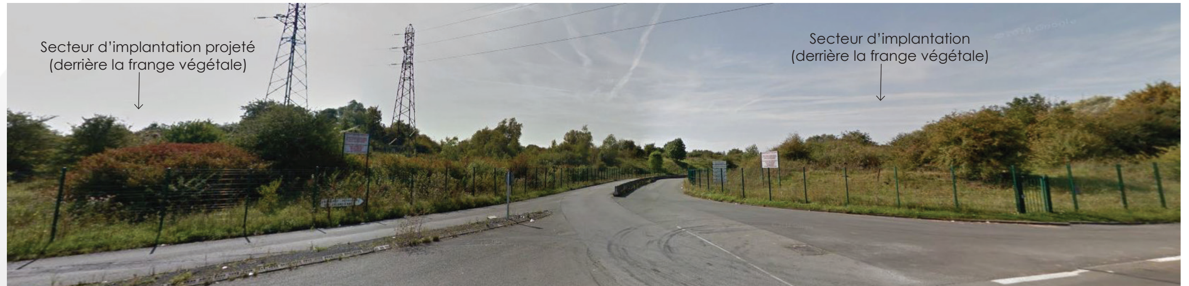
Entrée nord-est du site Total. Interface boisée.
